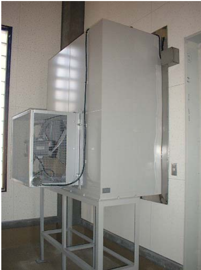
屋内壁面設置
