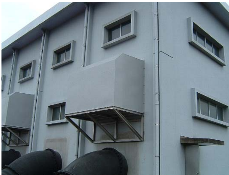
屋外壁面設置
